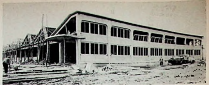
Neubau des Metz-Gehäuse- und Tonmöbelwerkes in Zirndorf
